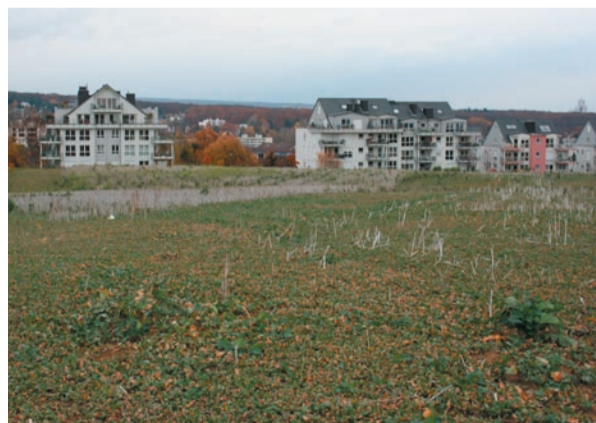
Das Sinai-Gelände ist noch Brachland – 2011 beginnt der Bau.
